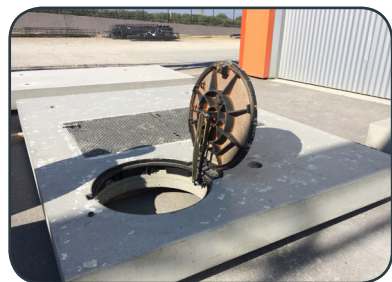
Dalle avec incorporation de tampon fonte
